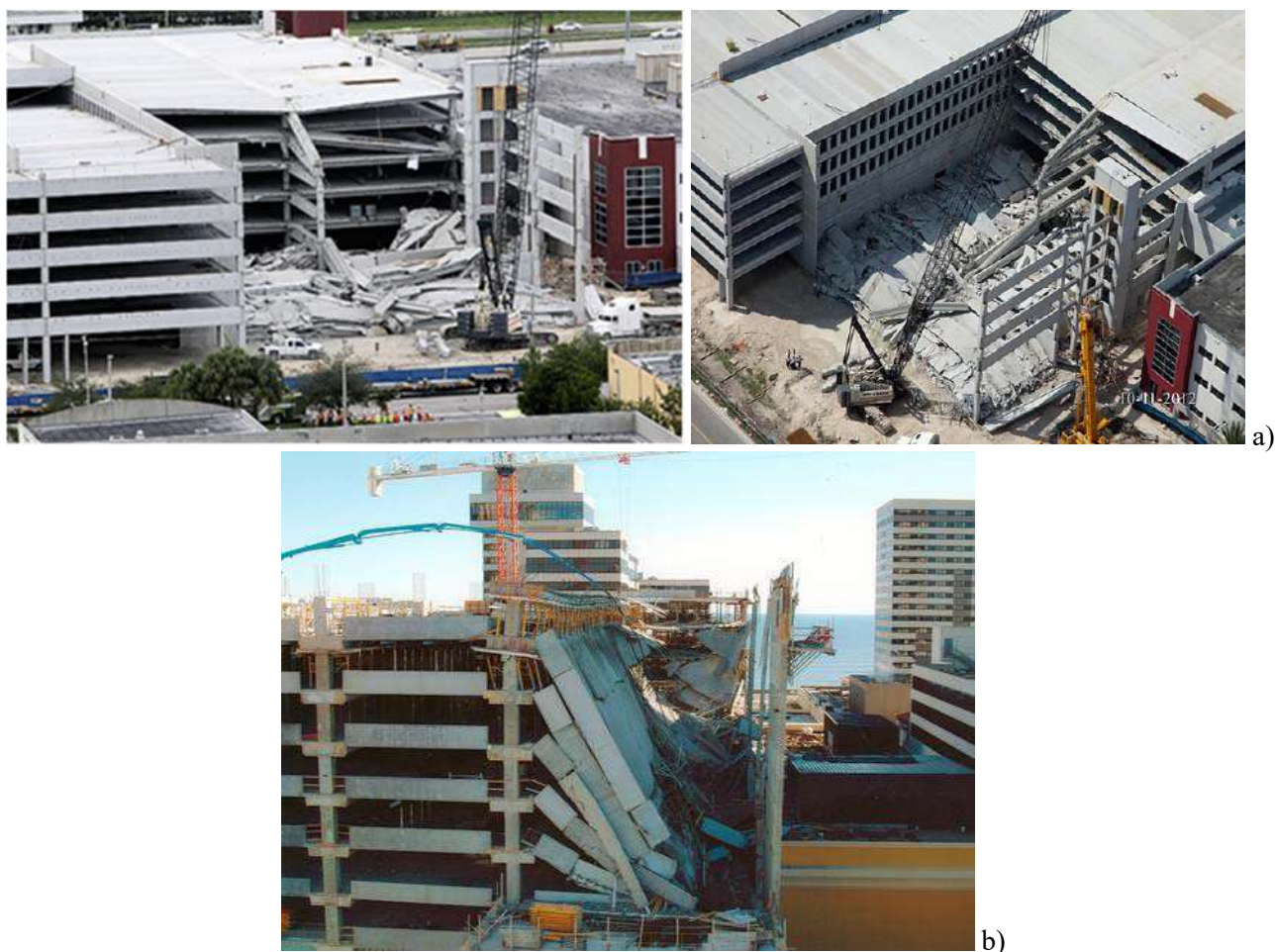
Figura 6-22 – Collasso progressivo e sproporzionato di struttura prefabbricata in fase di costruzione: a) a Miami (da www.osha.gov/doc/engineering/2013_r_02.html ); b) ad Atlantic City (da https://failures.wikispaces.com/Tropicana+Casino+Parking+Garage )
