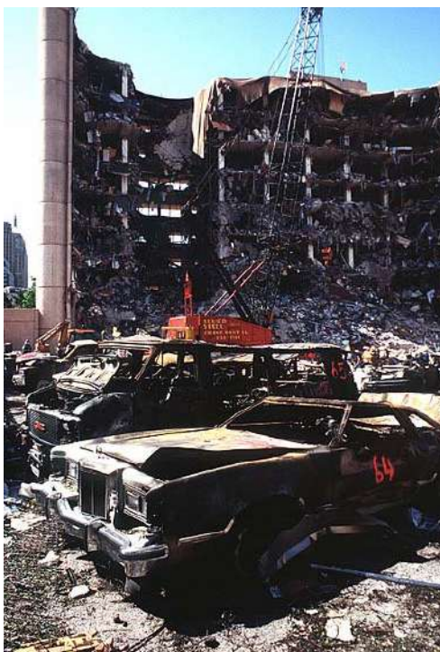
Figura 6-3 – Vista ravvicinata dell’edificio a seguito del collasso (da https://commons.wikimedia.org/wiki/File:Oklahomacitybombing-DF-ST-98-01356.jpg )
