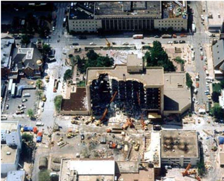
Figura 6-2 – Vista aerea dell'edificio e della parete vetrata sul lato nord a seguito del collasso (da https://commons.wikimedia.org/wiki/File:Murrah_Building_-_Aerial.jpg )
