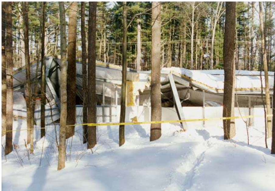
Figura 6-32 – Crollo della copertura del Jackson Landing Skating Rink (Ellingwood et al., 2007)
