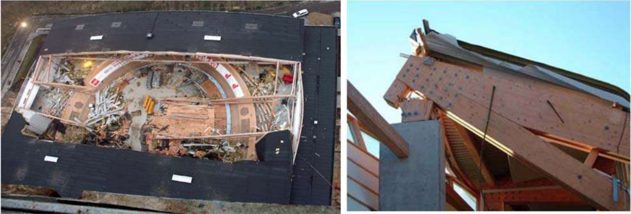
Figura 6-42 – Collasso della copertura lignea della Siemens Arena a Ballerup, Danimarca (da COST Action E55, 2010)
