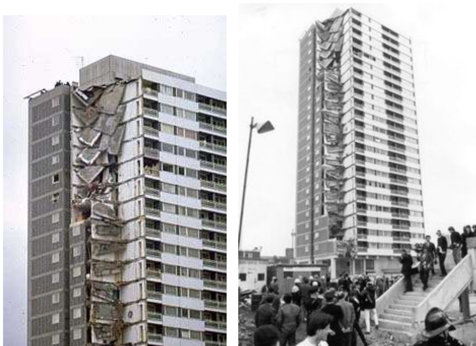
Figura 6-14 – Crollo progressivo di una porzione di edificio a pannelli prefabbricati (Ronan Point, East London) (da https://en.wikipedia.org/wiki/Ronan_Point )
